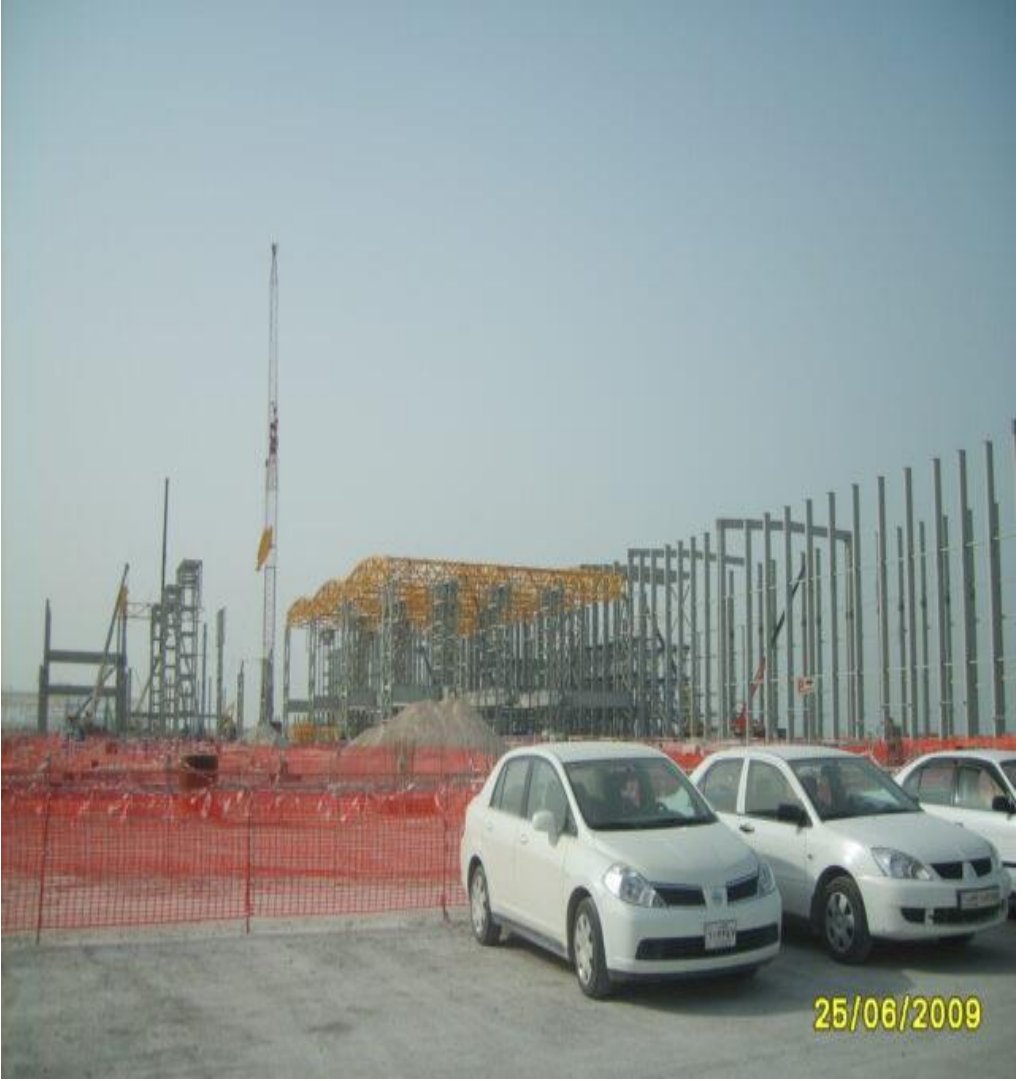
Cargo Terminal Assignment Area; Initial construction stage કાર્ગો ટર્મિનલ Assignment Area; બાંધકામના પ્રારંભિક તબક્કામાં
