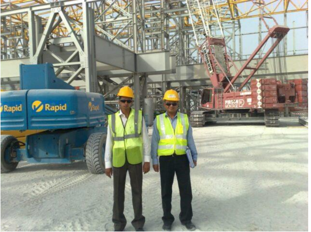
Nasirhusen Lotiya અને Matin Manman કાગો ટર્મિનલ સાઈટ ઇન્સ્પેક્શન દરમિયાન Nasirhusen Lotiya and Matin Manman during cargo terminal site inspection
